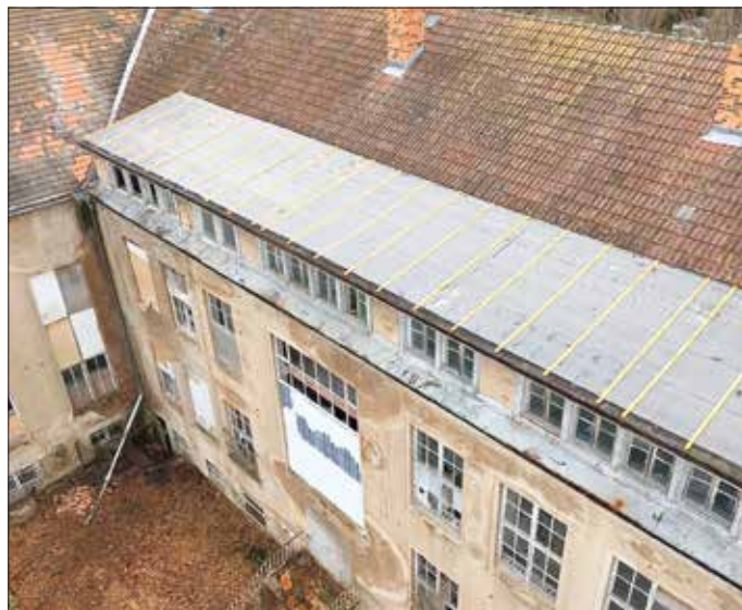
Ein Blick von oben auf die Dachgaube
