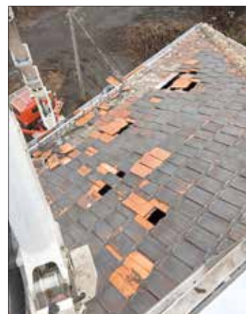
Die Defekte am Dach sind deutlich zu sehen
