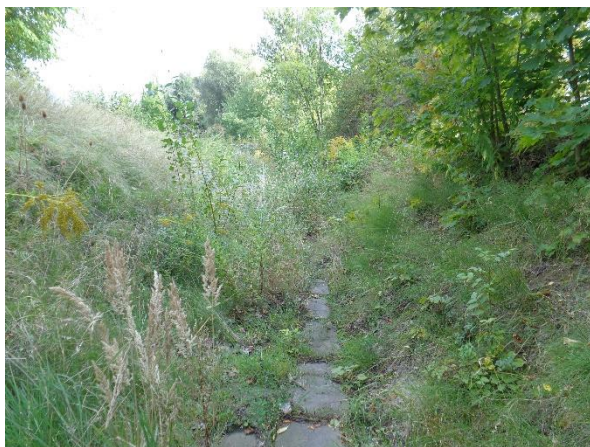
Die Geisel – trocken gefallener Graben mit Betonplatten im Sohlengraben
